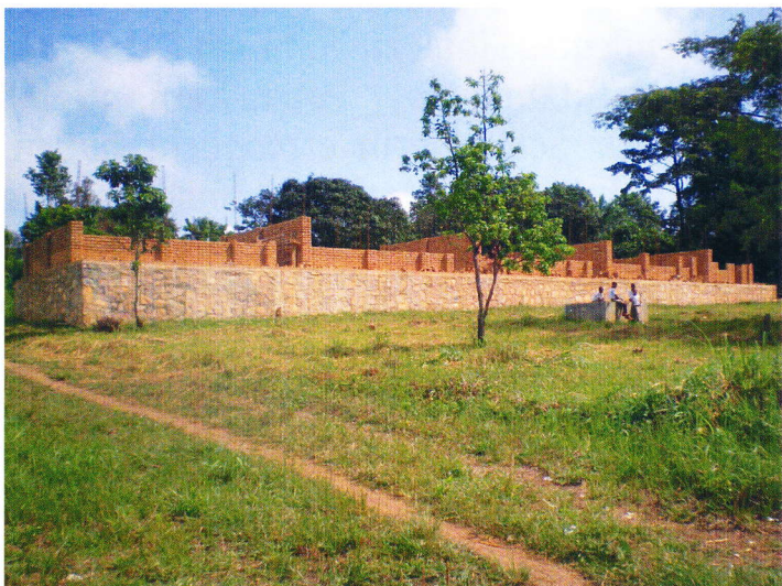
Fundament der neuen Schule
