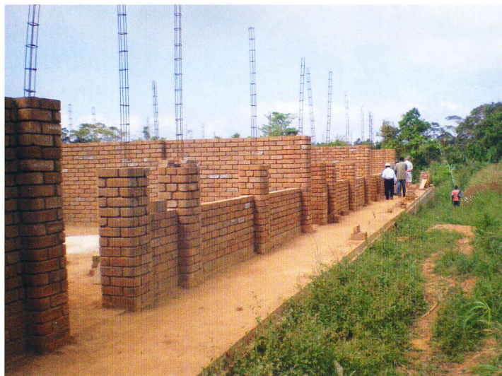
Im Bau: vier Klassenräume und ein Lehrerzimmer
